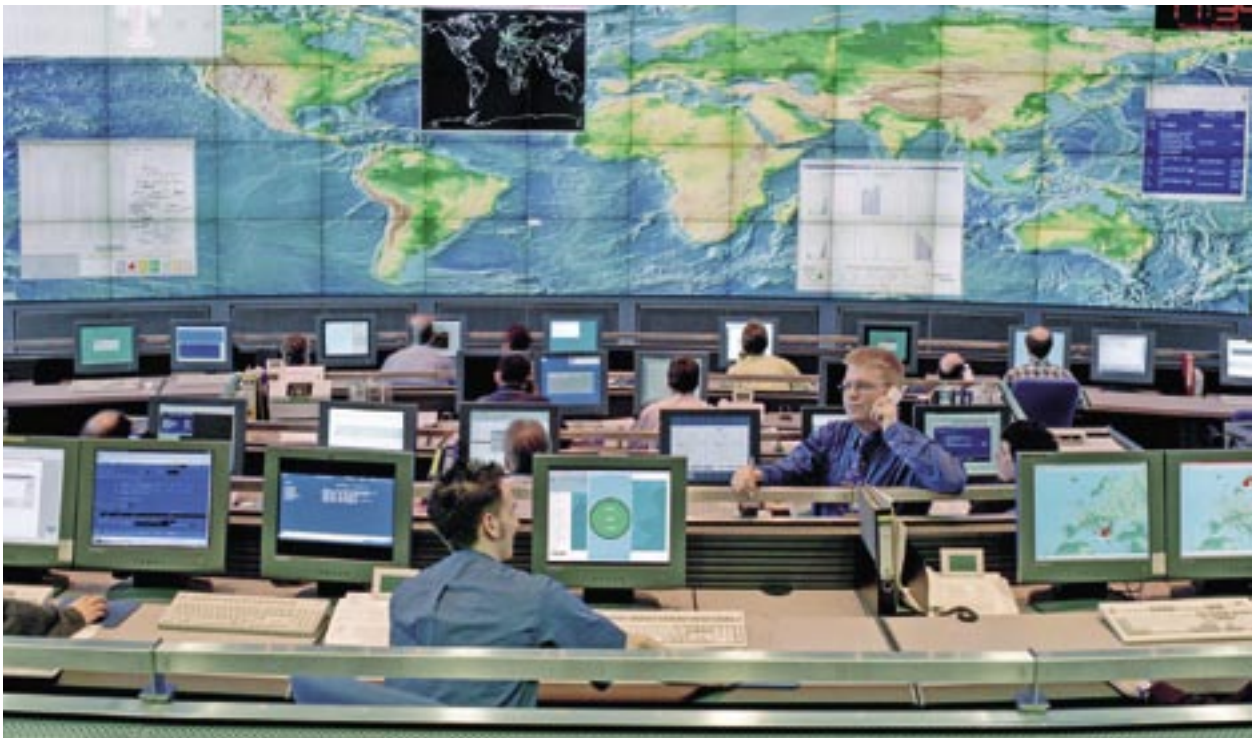
Deutsche Telekom AG Control Centre
